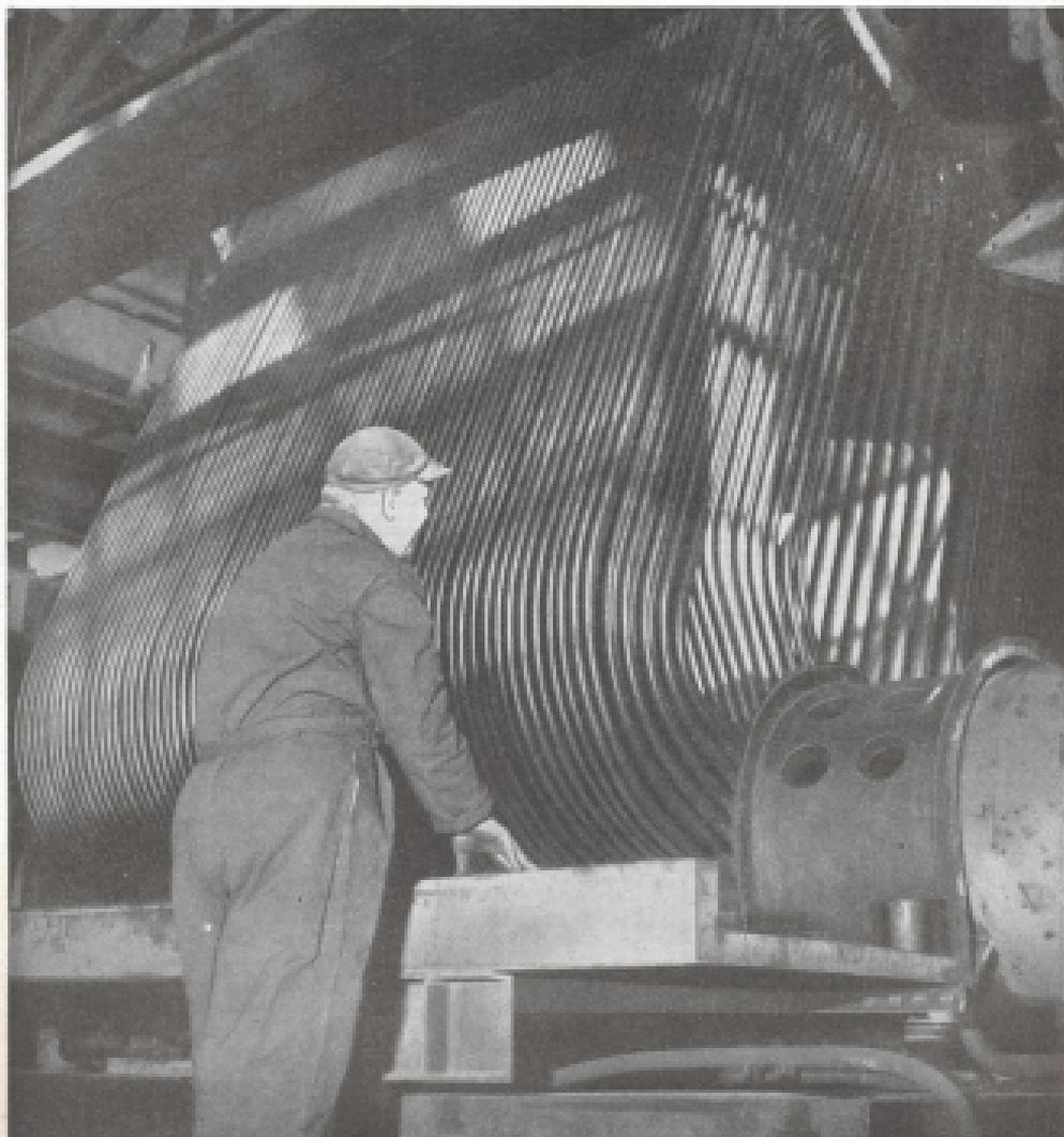
Edificio a velli d'acqua Ansaldo-Foschi Wheeler in costruzione al Boccaccio. In primo piano il caldaio Henschel-Maschinen.
